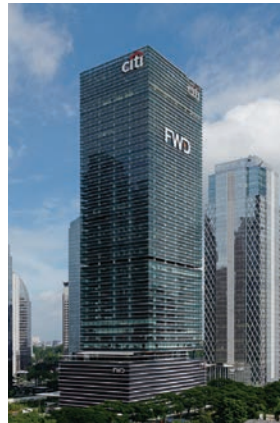
Pacific Century Place Jakarta ジャカルタ、インドネシア セラタイカ2号
