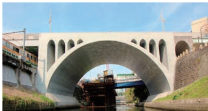
聖橋長寿命化工事 (RCアーチ) セラミクリートF
