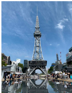
新・名古屋テレビ塔「MIRAI TOWER」 愛知県 SKタイカコート
