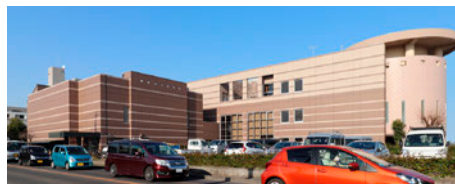
宮原コミュニティセンター中規模修繕工事 埼玉県 グラニクイーンローラー用
