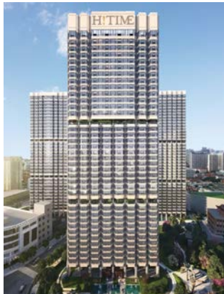
上海海泰北外滩ビル 中国・上海 シボカケンネオ、セラタイカ2号など
