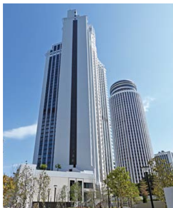
ホープウェルセンターII新築工事 香港 ファインメタクイーンIN、グラニビエーレなど
