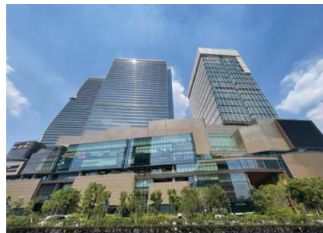
One Bangkok R1 Cinema Building タイ・バンコク クリーンマイルドウレタン艶有り
