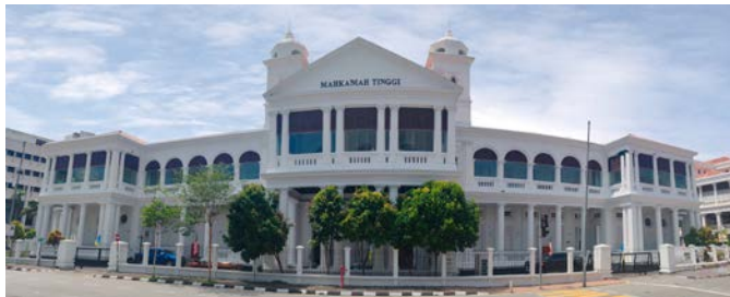
ペナン州高等裁判所外壁改装 マレーシア コンボシリコンW55、アクリスターライト、SKグロスソフト
