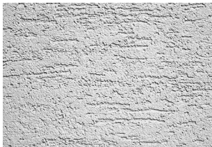
Tail-S ※テールS P41 音 寒水石1.5厘 施 SK仕上げこて
