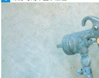
●セラミクリートフレッシュ (無泡ローラー、刷毛でも施工できます)
