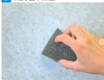
●セラミクリート補修材 (必要に応じて実施)
