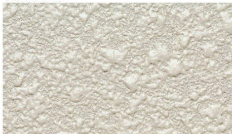
吹放し仕上げ
