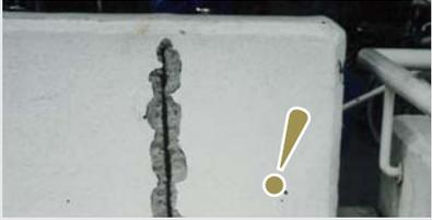
コンクリートは、炭酸ガスにより中性化が進み劣化します。中性化が進行すると、コンクリート内のアルカリ性が消失し、中性化が鉄筋表面に達し、鉄筋爆裂が生じます。
