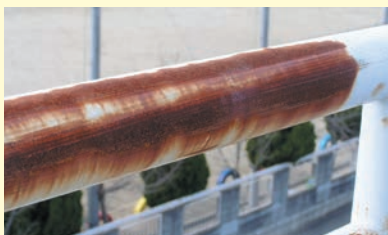
1. 下地確認 さびの発生状況の確認
