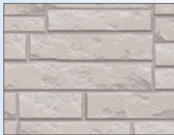
新築時/既存の外壁
